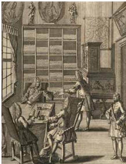
Es müssen die Vorgaben eingehalten werden.
